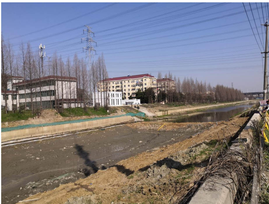
图 5.2.1-3 河道疏浚余水自然沉淀
