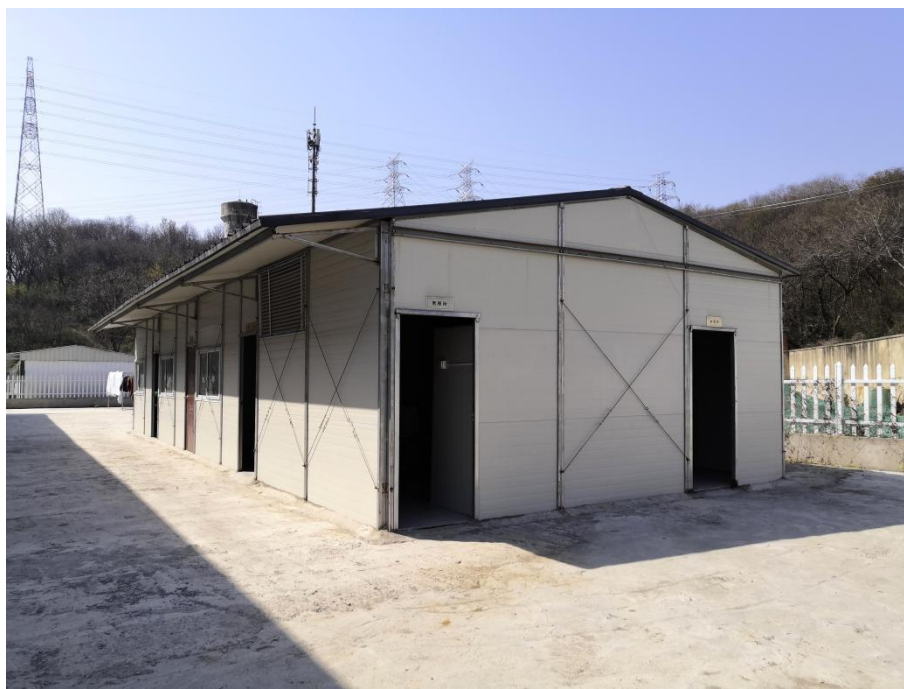
图 5.2.1-1 施工项目部卫生间
