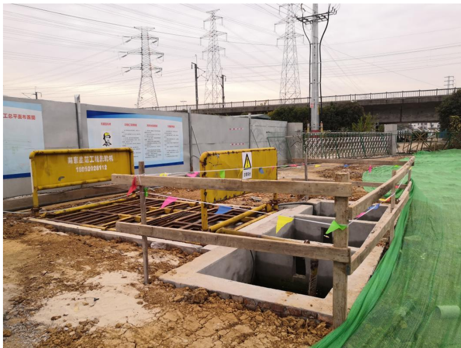
图 5.2.1-4 施工现场车辆冲洗区
