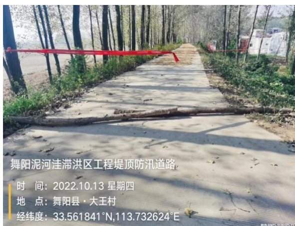
堤顶防汛道路
