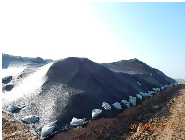
临时弃土苫盖
