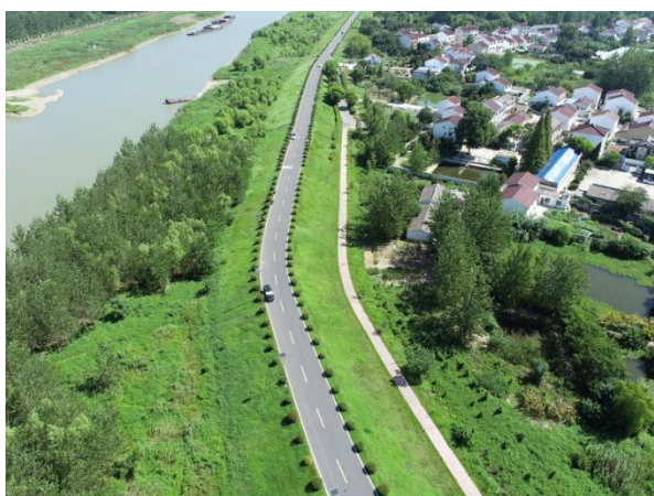
双城圩段堤防工程
