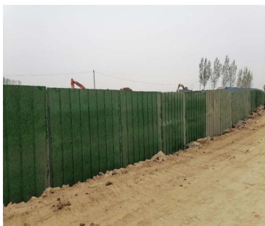
施工场地围挡
