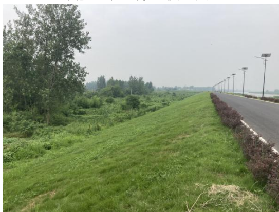
草皮护坡工程
