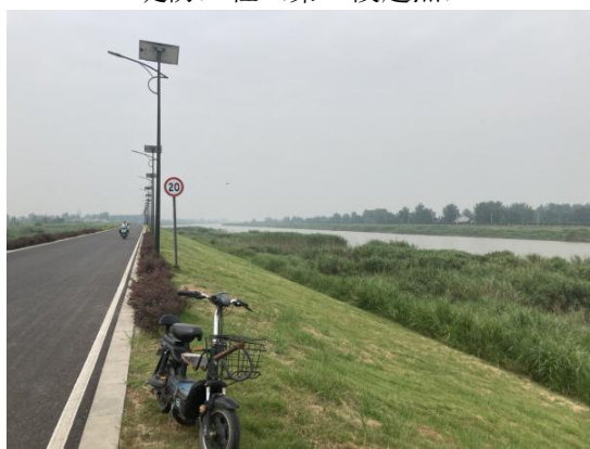
堤防工程（第二段终点）
