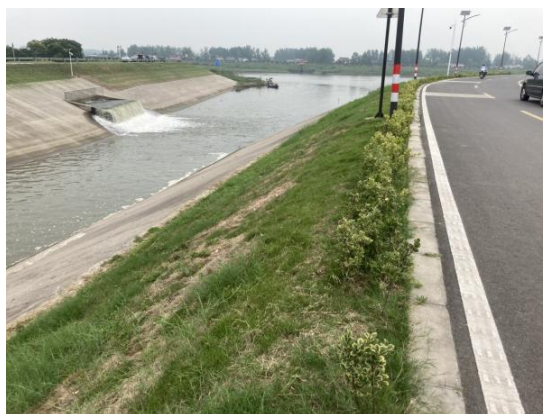
堤防工程（第一段起点）
