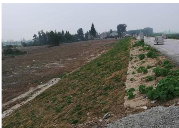
施工临时占地
