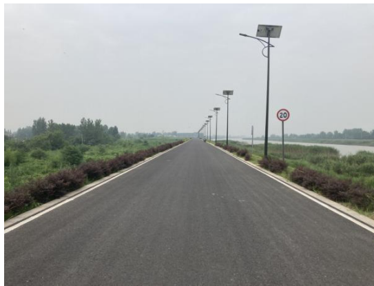
堤顶道路工程
