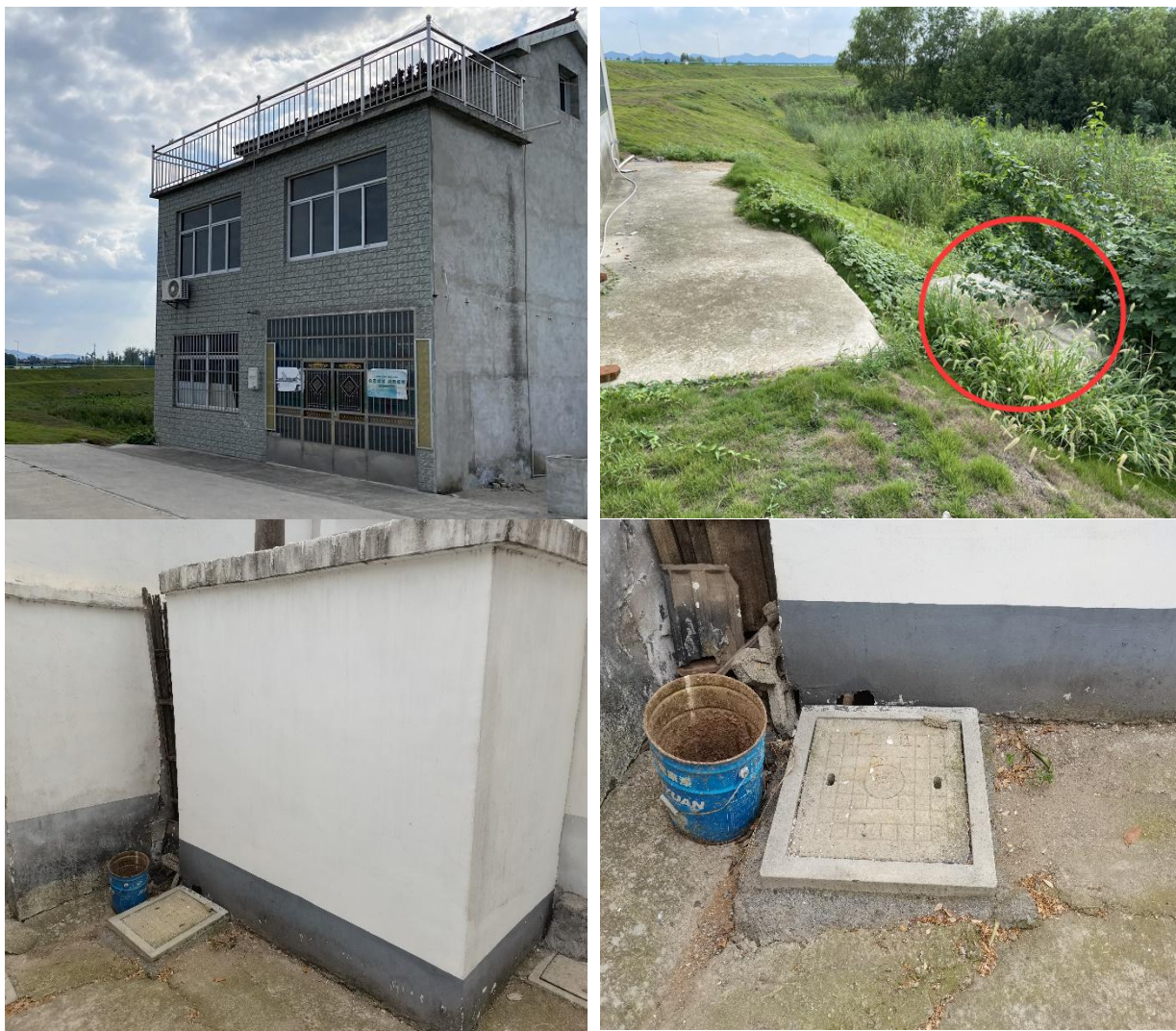
图 5.2-1 施工营地化粪池设施现场照片
