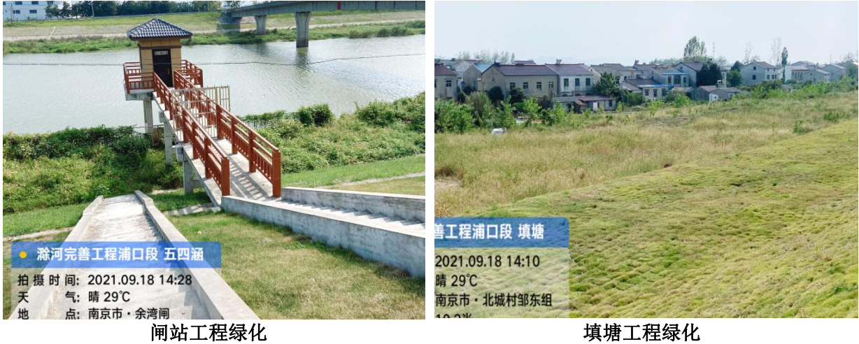
图 6.1-1 工程沿线施工迹地绿化
