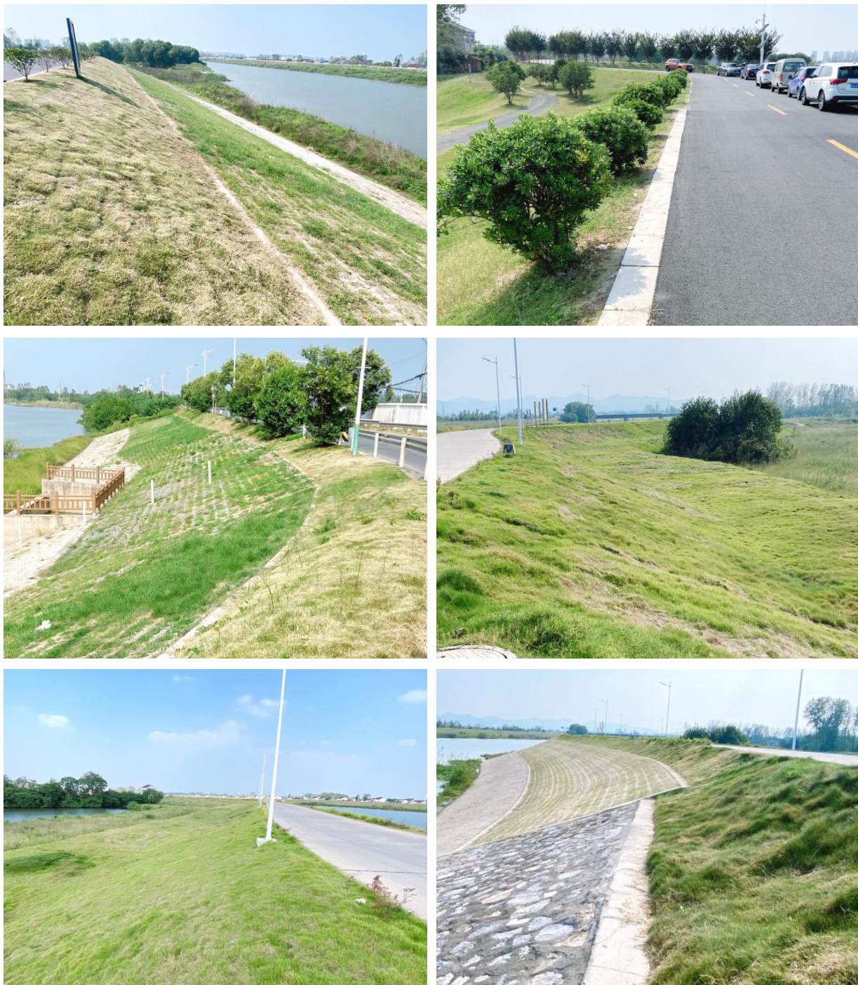
护坡工程绿化
