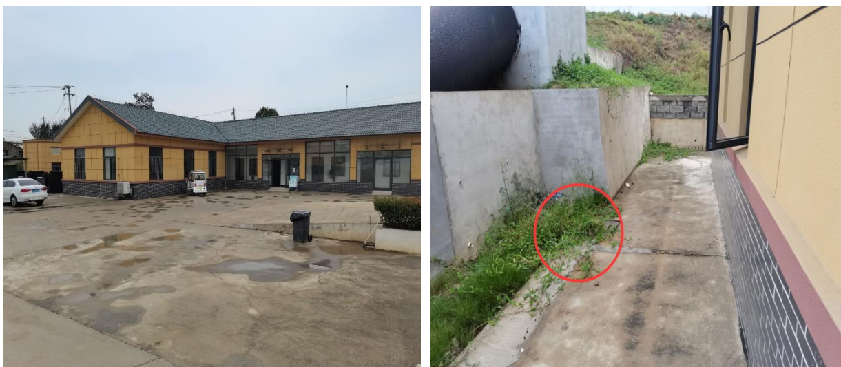
图 5.2-2 余家湾泵站管理房内配备的化粪池照片
