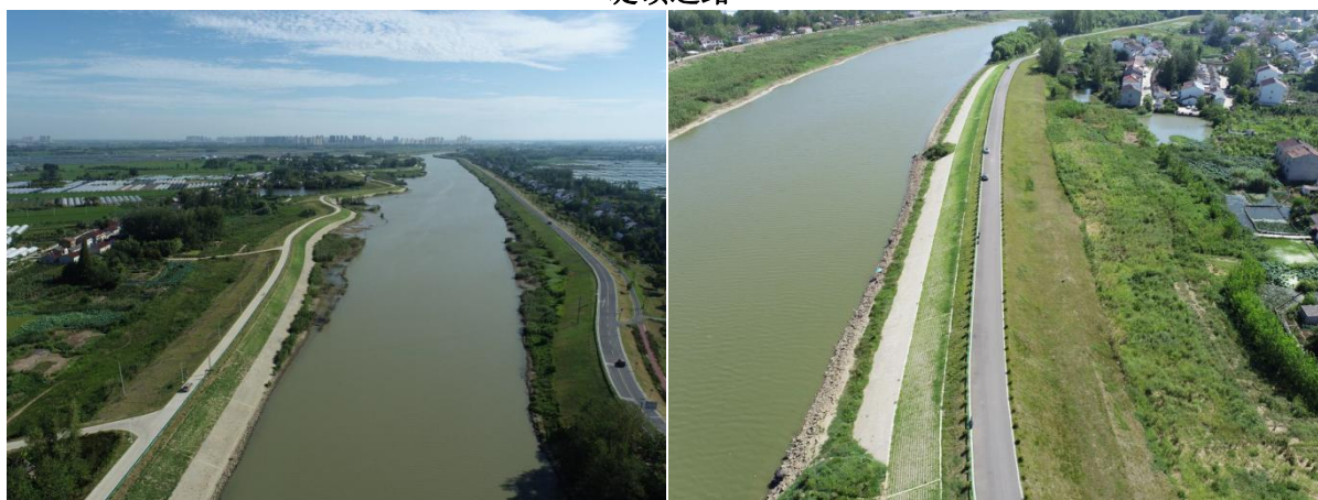
三合圩堤防工程
