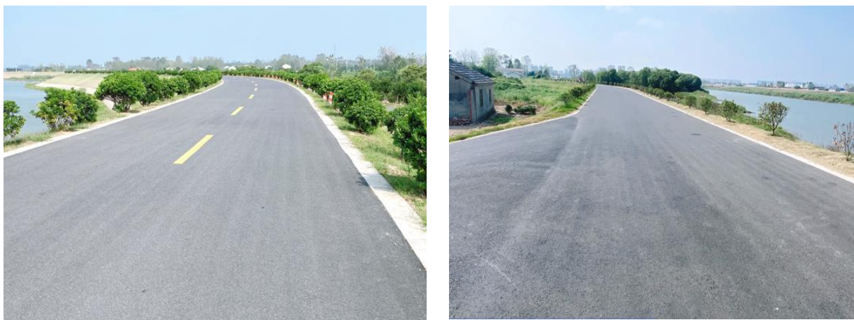
道路沿线景观现状
