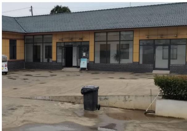
运行期泵房垃圾收集设施照片
