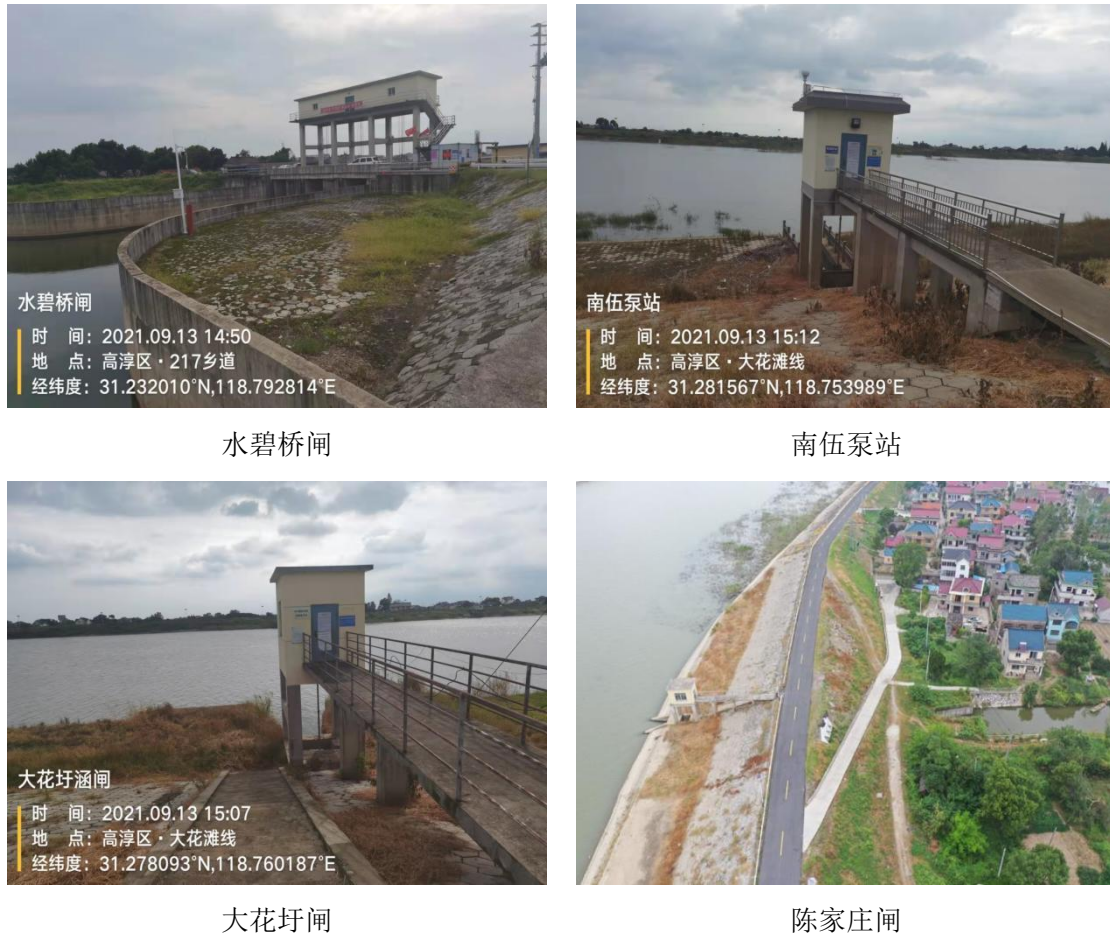
图 2.2-3 涵闸泵站现状照片
