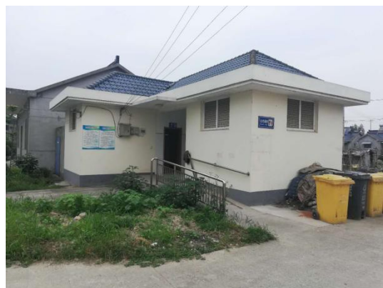
水碧桥村公共厕所及垃圾堆放点
