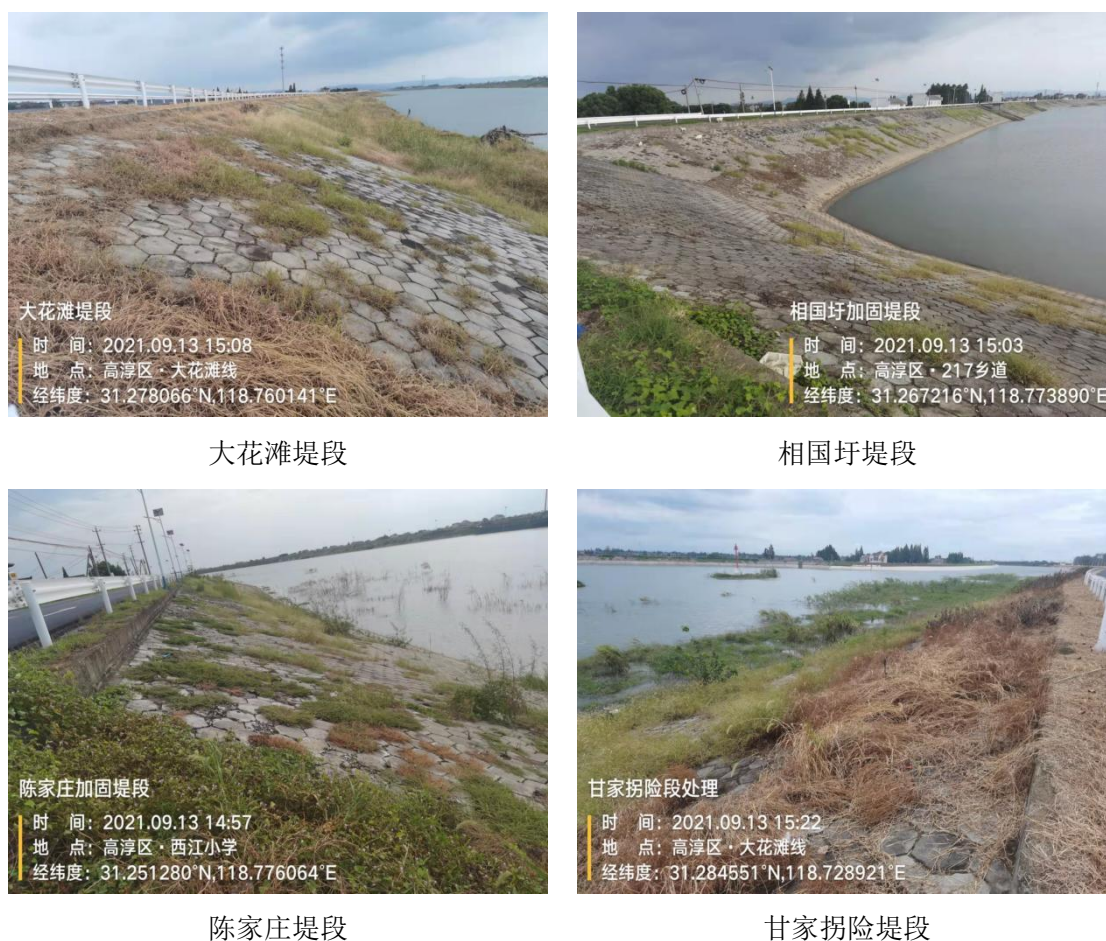
图 2.2-2 堤防现状照片
