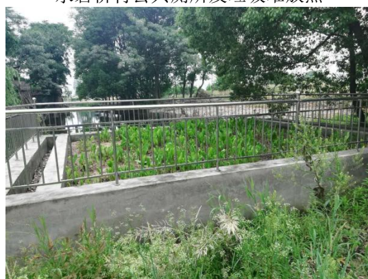
水碧桥村生活污水处理设施
