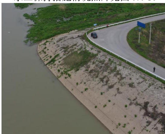
混凝土预制块护坡 (甘家拐险滩段)
