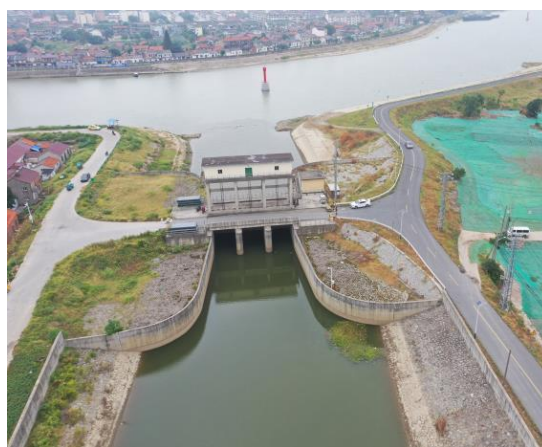
浆砌石护坡 (水碧桥闸)
