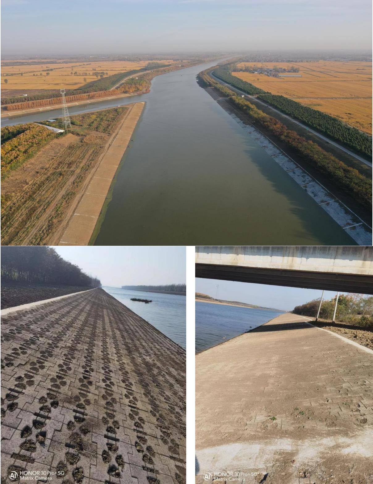
图 2.1-2 怀洪新河两岸护坡、护岸工程现状图片
