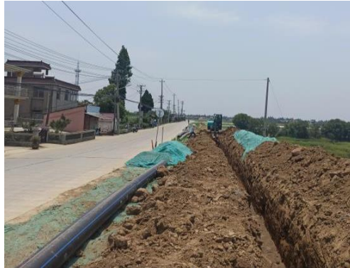
雨水管网施工
