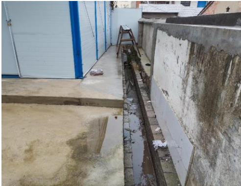
项目部排水沟
