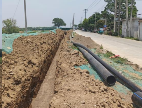
雨水管网施工
