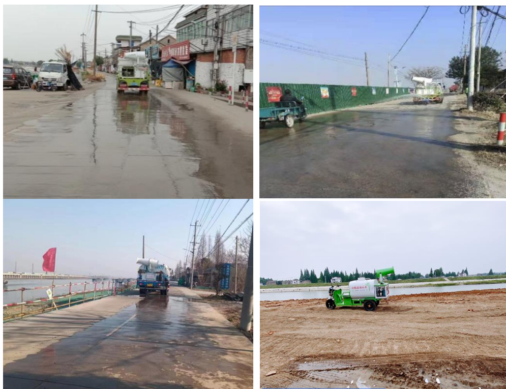
施工现场洒水降尘
