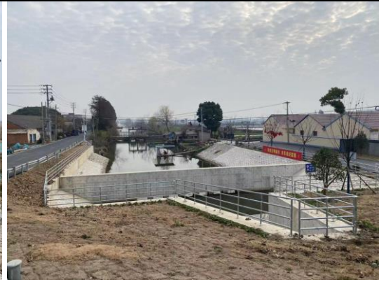
西陡门涵闸沉螺池
