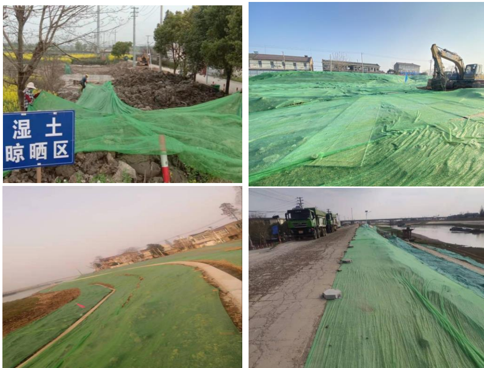
临时堆土、裸土覆盖
